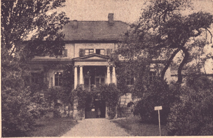
Mittelbau des Dörnberg-Palais'
