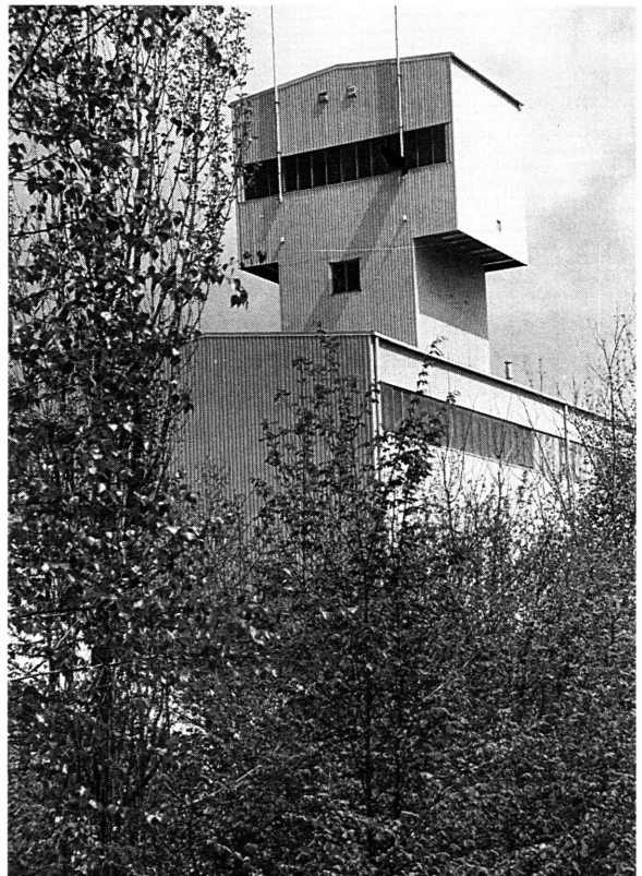
Abb.9: 37m hoher Leonie-Förderturm mit Turmfördermaschine und Schachthalle. (Werksfoto 1985)
