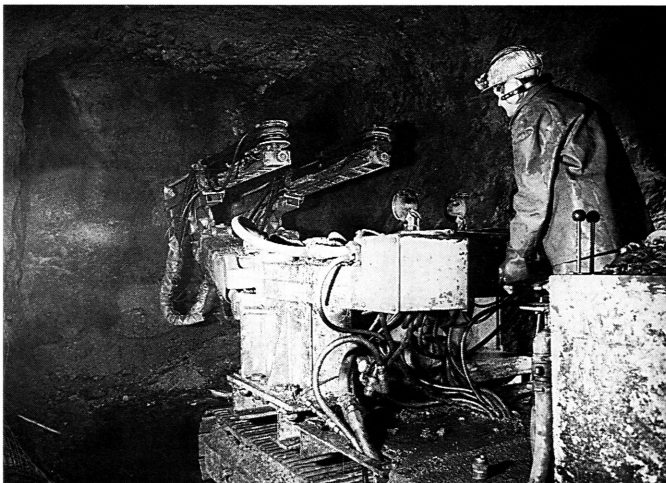
Abb.6: Vollelektrohydraulischer zweiarmiger SIG-Bohrwagen
