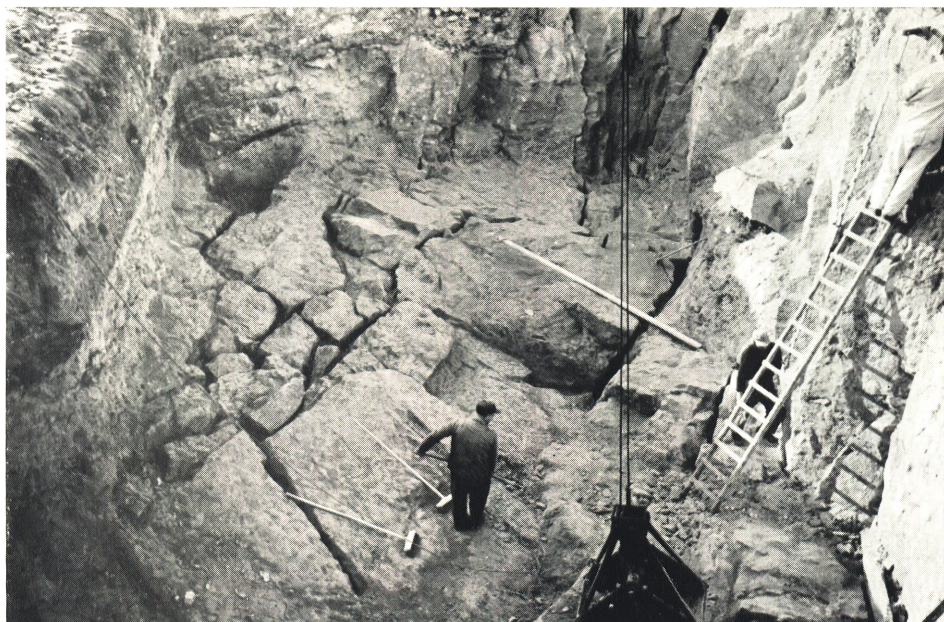
Blick v. O. in die Baugrube. Rechts (N): anstehender Knollensandstein, links (S): Abraum des alten Steinbruchs. Die Längsspalten laufen parallel zur Donau; die abgerutschten Felspartien sind quer gerissen und schwach gegen N. geneigt (Richtung der Besen und der Latte)
