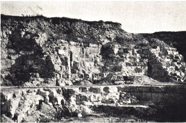
Abb. 2. Steinbruch von Blödt-Rößner bei Lengendorf südlich von Amberg. Die Höhe des Bruches beträgt etwa 17 m. Oben sind die leichter verwitternden Crussoliensis -Mergel aufgeschlossen. Darunter folgen die hie und da Silex-führenden Bänke des sog. Splitterkalkes des Malm 2. Diese Schichten sind hier besonders reich an Ataxioceras und Rasenia -Arten.
